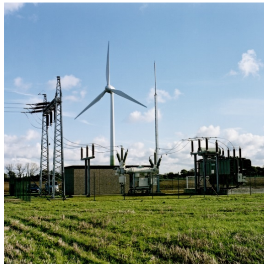
Abbildung 3: Hybridschaltanlage für 110 kV 11
